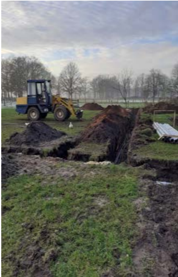
Foto: Grondwerk toekomstige camping
